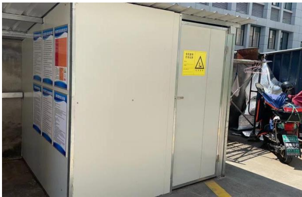
附图 1.2 危废暂存间（室外）
